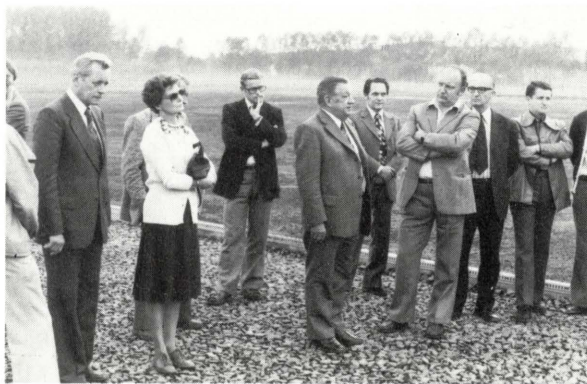
Baustellenbesichtigung: Die Laufbahn im Schotterbett.
