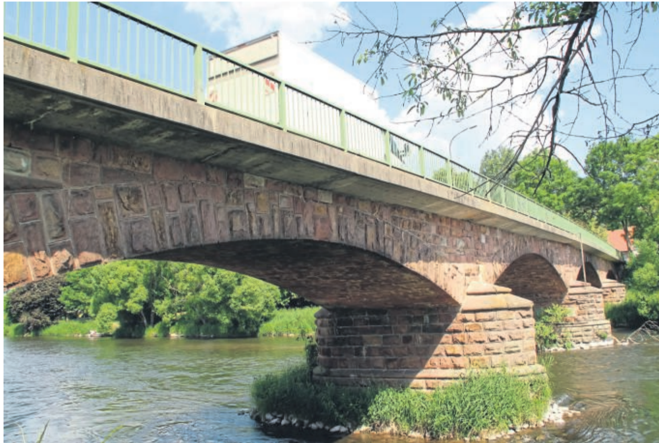
Historisches Bauwerk: In drei Bögen überspannt die Sandsteinbrücke in Brunslar die Eder. Das Bauwerk stammt aus dem Jahr 1890. Hessen Mobil hatte im April Probebohrungen vorgenommen. Die sogenannten Erkundungsbohrungen dienen, wie es offiziell hieß, „der Feststellung der Materialeigenschaften der Natursteingewölbebrücken“.
